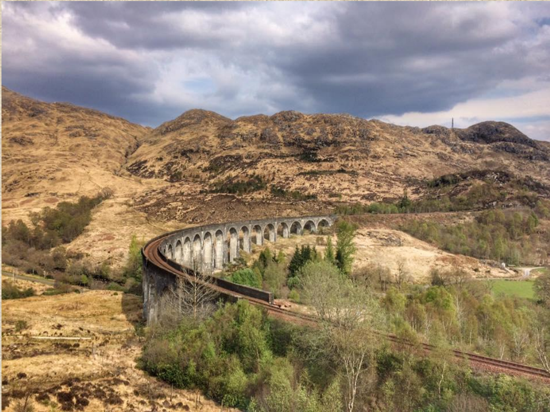
Viaduc de Glenfinnan
